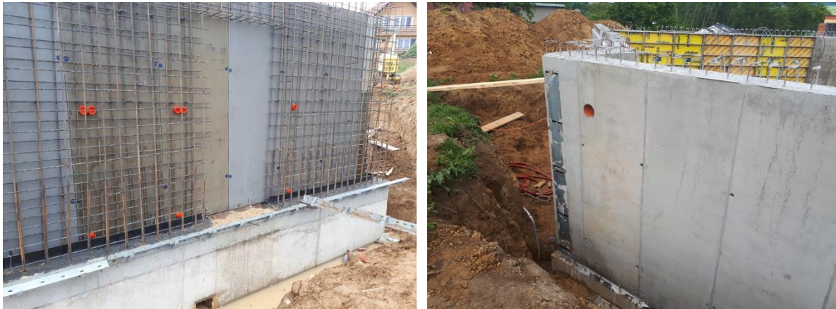
Obr. 3: Príprava výstuže a debnenia nosnej steny (vľavo) a hotová ŽB stena (vpravo)
