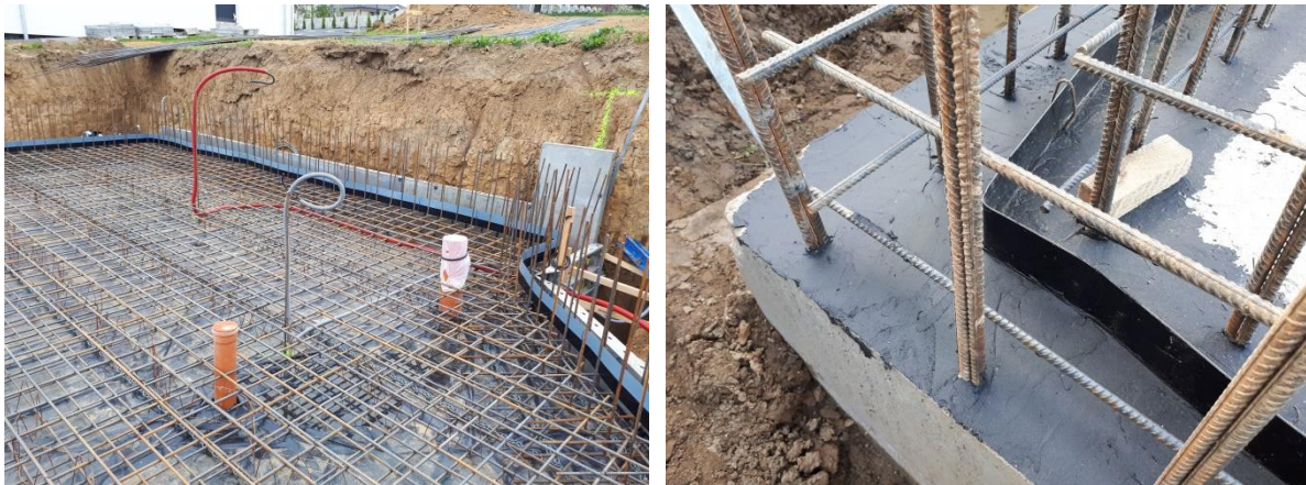
Obr. 2: Tesniaci plechový pás pred realizáciou dosky (vľavo) a po realizácií (vpravo)
